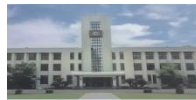
① 1号館 (国登録有形文化財) (旧大阪商科大学本部本館) 新築と左右対称の立面が特徴的で、柱型窓によって水平と垂直を強調するなど新しい時代の造形美をみることが出来る。
