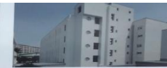
③ 倉庫棟 (旧大阪商科大学書庫棟) 書庫の間隔に設けられた1.4mの列柱が特徴的な外観となっており、丸窓や階段室のアーチなど、随所に円が使われている。
