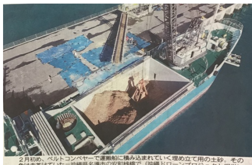
2月初め、ベルトコンベヤーで運搬船に積み込まれていく埋め立て用の土砂。その色は赤茶けていた＝沖縄県名護市の安和棧橋で（沖縄ドローンプロジェクト提供）
