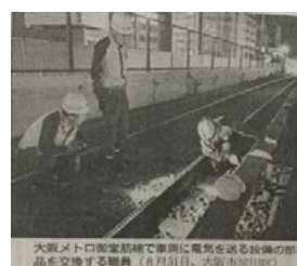
大阪メトロ御堂筋線で車両に電気を送る設備の部品を交換する職員（8月31日、大阪市西区）
